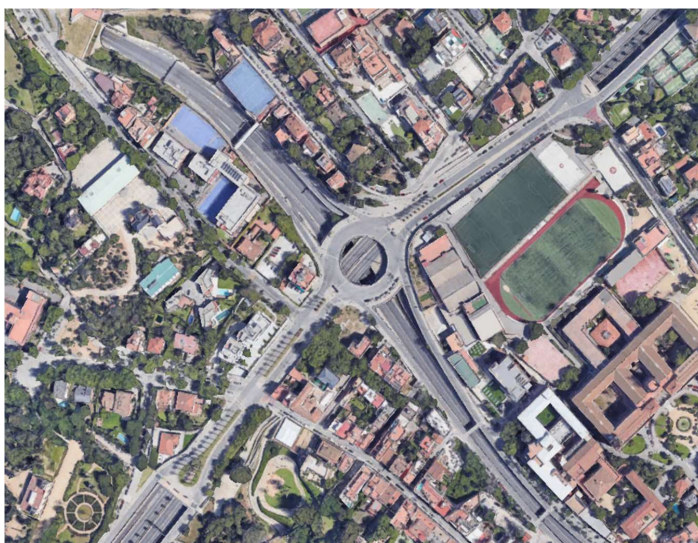
Vista aèria Túnel Borràs i Ramal IJ
